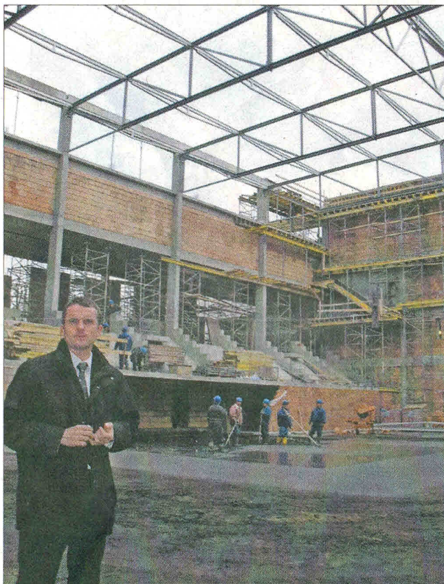
Burmistrz Artur Kozioł na budowie Centrum Rekreacyjno-Edukacyjnego. FOT. JOLANTA BIAŁEK
