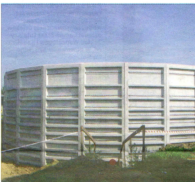
Dzięki unijnej dotacji w Gdowie rozbudowywana jest oczyszczalnia ścieków. Niebawem w tej gminie ruszy kolejna sanitarna inwestycja dofinansowana z UE. FOT. ARCHIWUM
